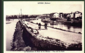
Vue de la gare d'eau modernisée, carte postale, années 1930. Archives Municipales de Givors, fond Jean-Michel Duhart.
